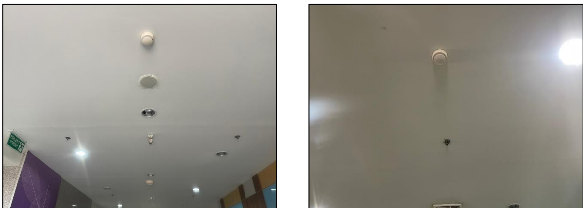
รูปที่ 2.2-33 ระบบสัญญาณเตือนเพลิงไหม้โดยมือ กริ่งสัญญาณเตือนไฟไหม้
