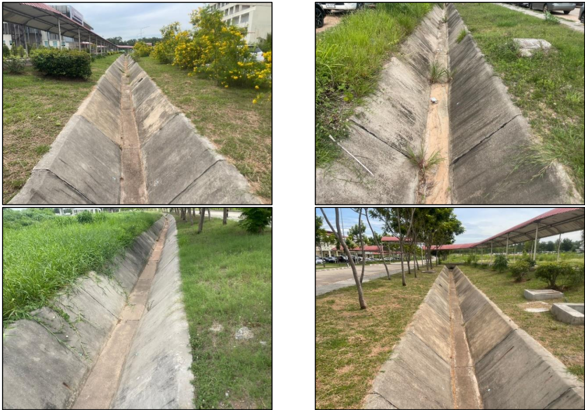
รูปที่ 2.2-22 รางระบายน้ำฝนของโครงการ
